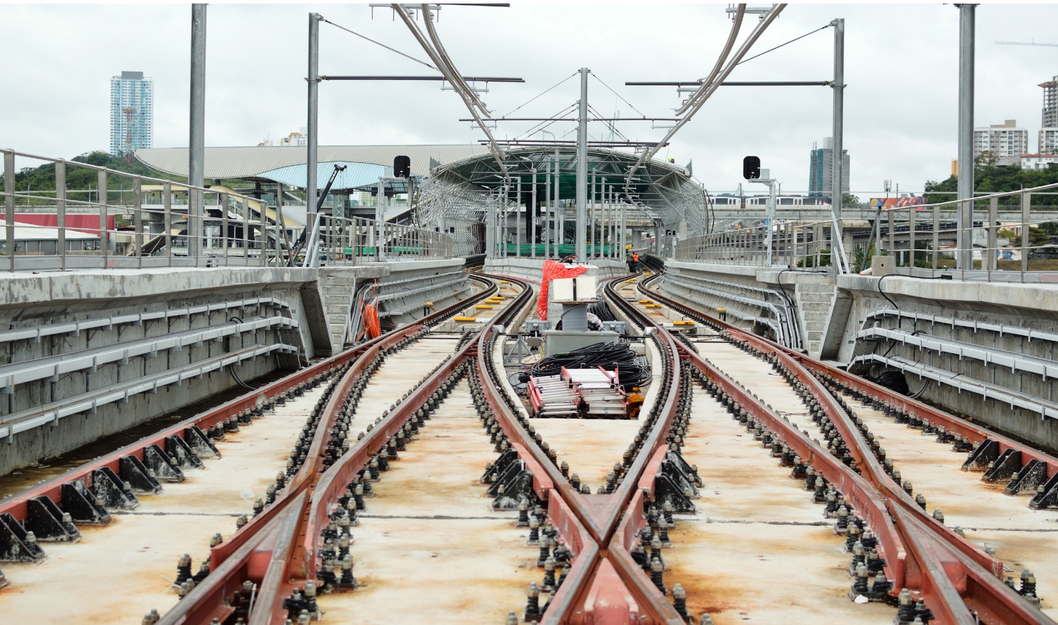
Vías del metro de la Línea 2 del Metro de Panamá.
