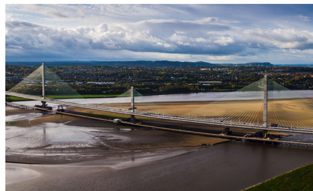
Puente de Mersey, Reino Unido.
